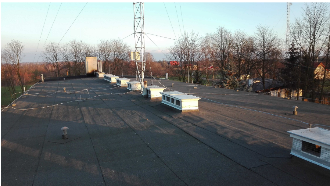
Rys nr 6. Dach nad budynkiem Szkoły Podstawowej w Krysku.
