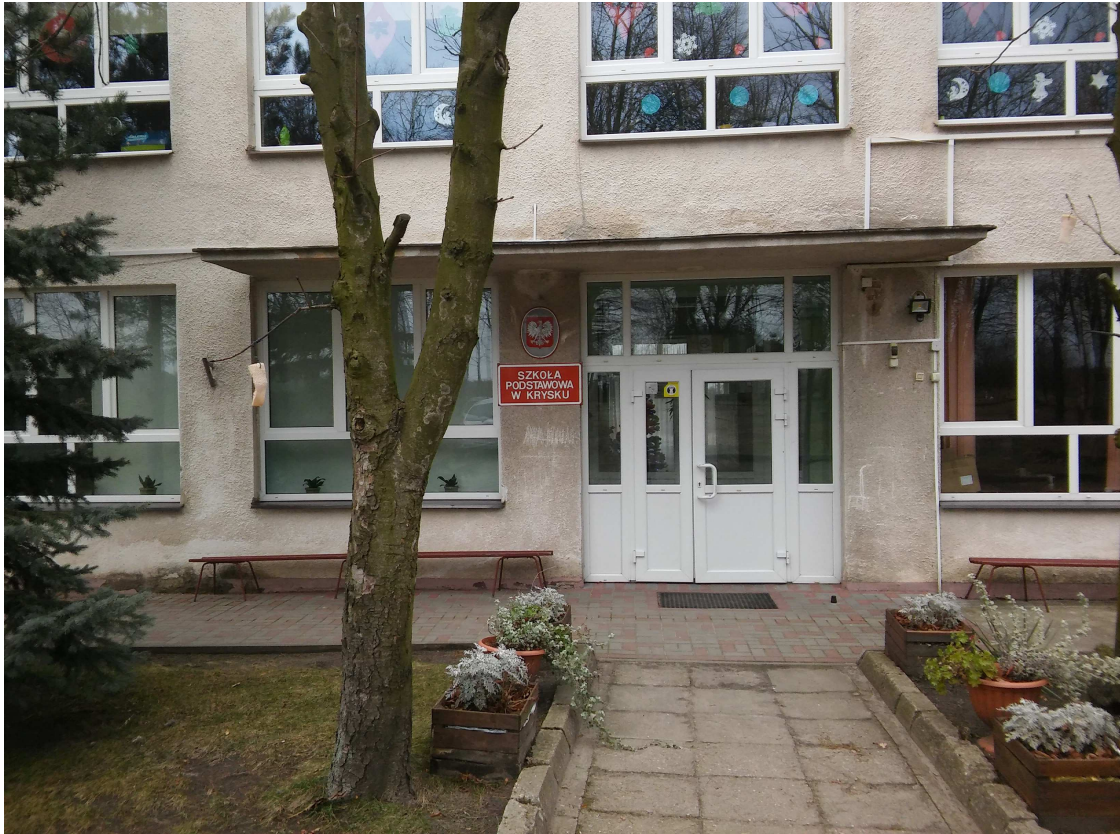
Rys nr 7. Wymienione okna PVC.
