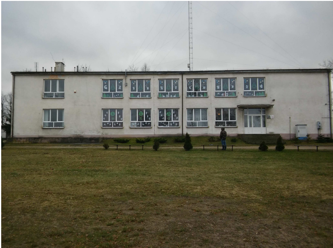
Rys nr 1. Elewacja frontowa Szkoły Podstawowej w Krysku (elewacja północno-zachodnia).
