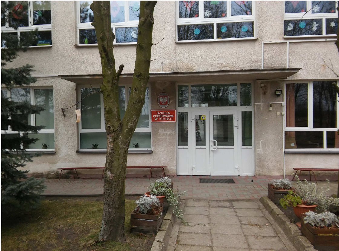
Rys nr 7. Wymienione okna PVC.
