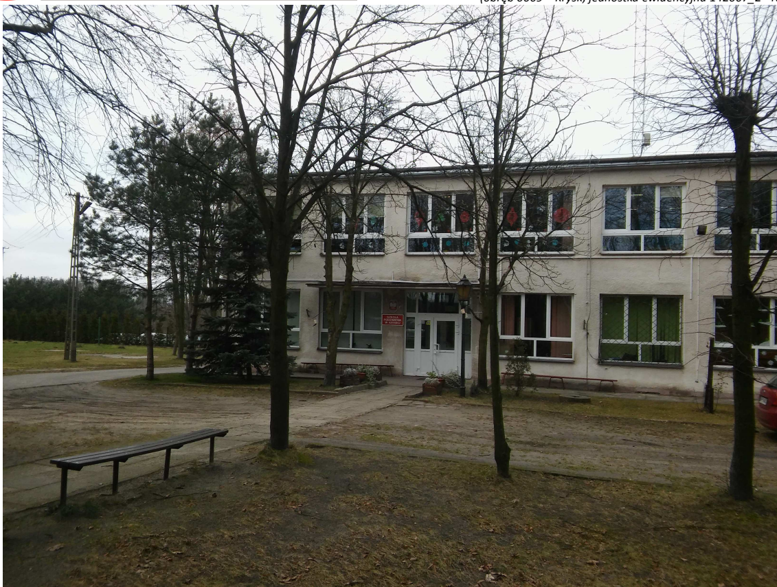
Rys nr 2. Elewacja wejściowa Szkoły Podstawowej w Krysku (elewacja południowo-wschodnia).
