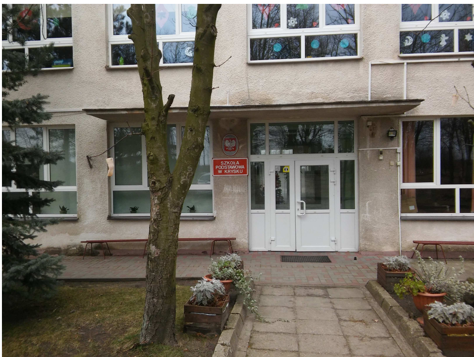
Rys nr 7. Wymienione okna PVC.
