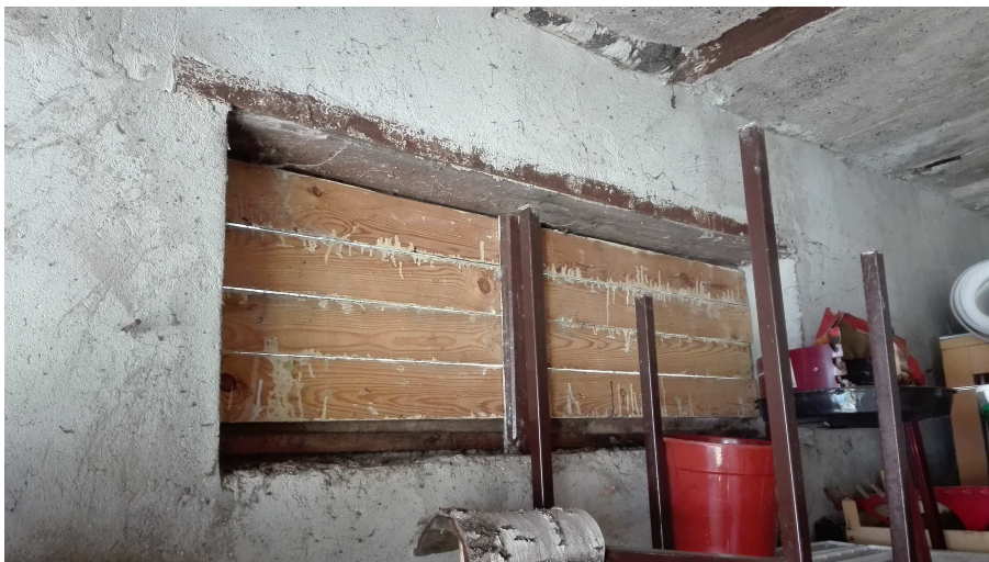
Rys nr 7. Brak tynków wewnętrznych w pomieszczeniu gospodarczym.
