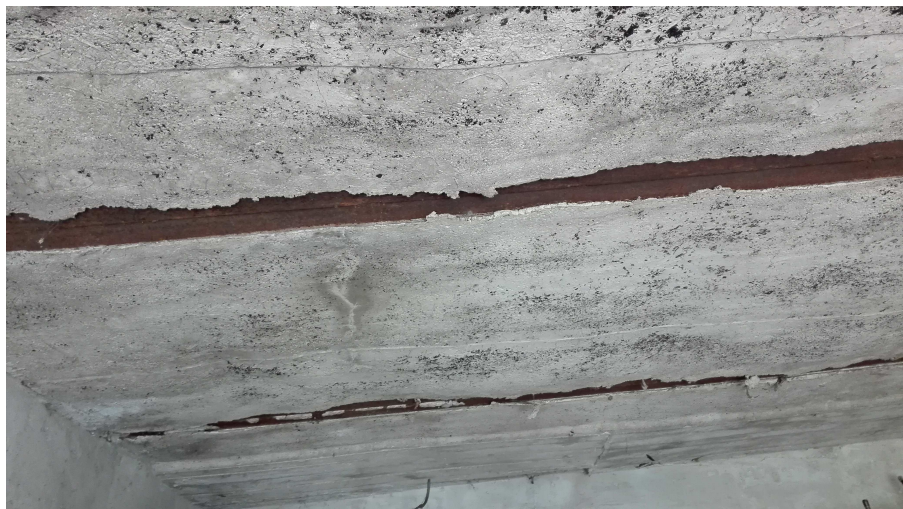
Rys nr 9. Widok płyty stropodachu od spodu.
