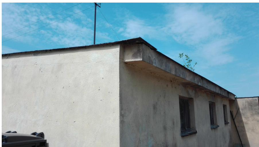
Rys nr 10. Drewniane okna zamontowane w budynku.
