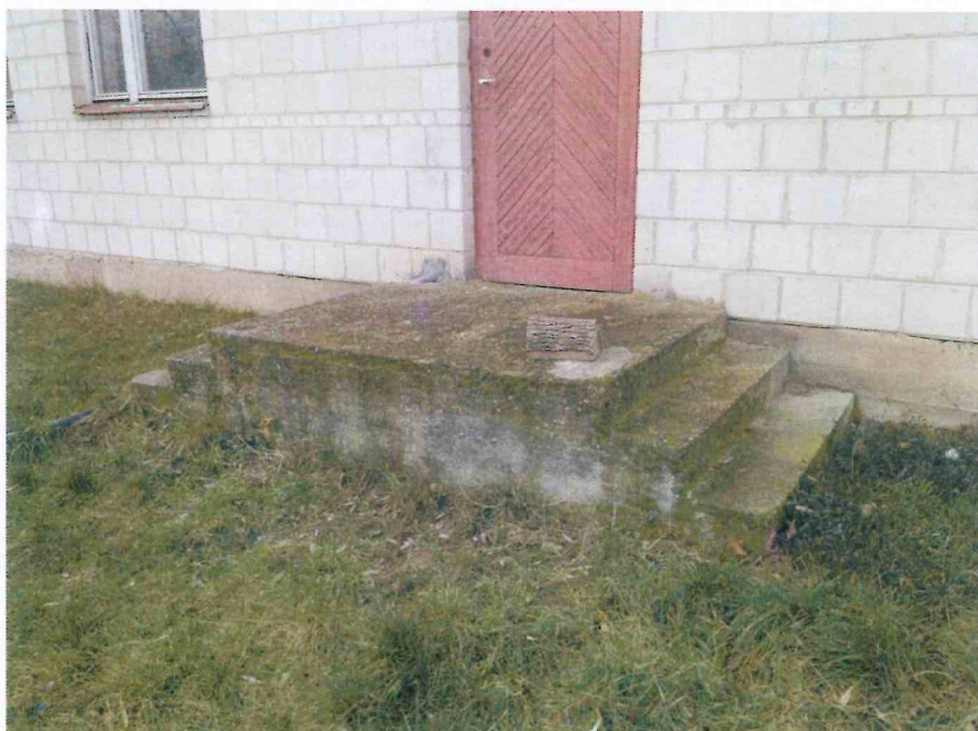
Rys nr 7. Schody od strony wschodniej budynku.
