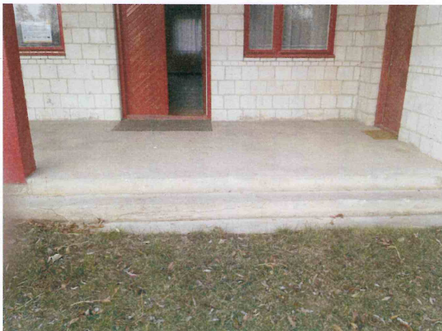
Rys nr 6. Główne schody prowadzące do budynku remizy OSP w Strzembowie.
