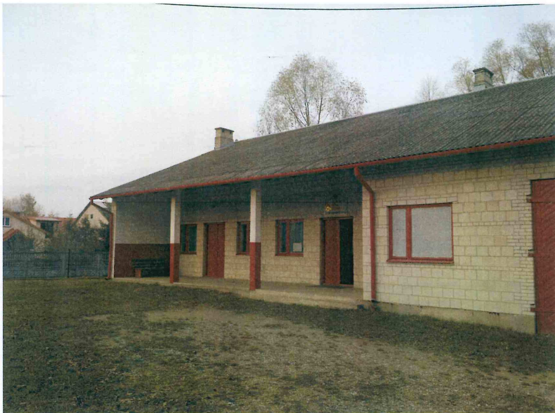
Rys nr 1. Elewacja frontowa (południowa) budynku Remizy OSP w Strzembowie
