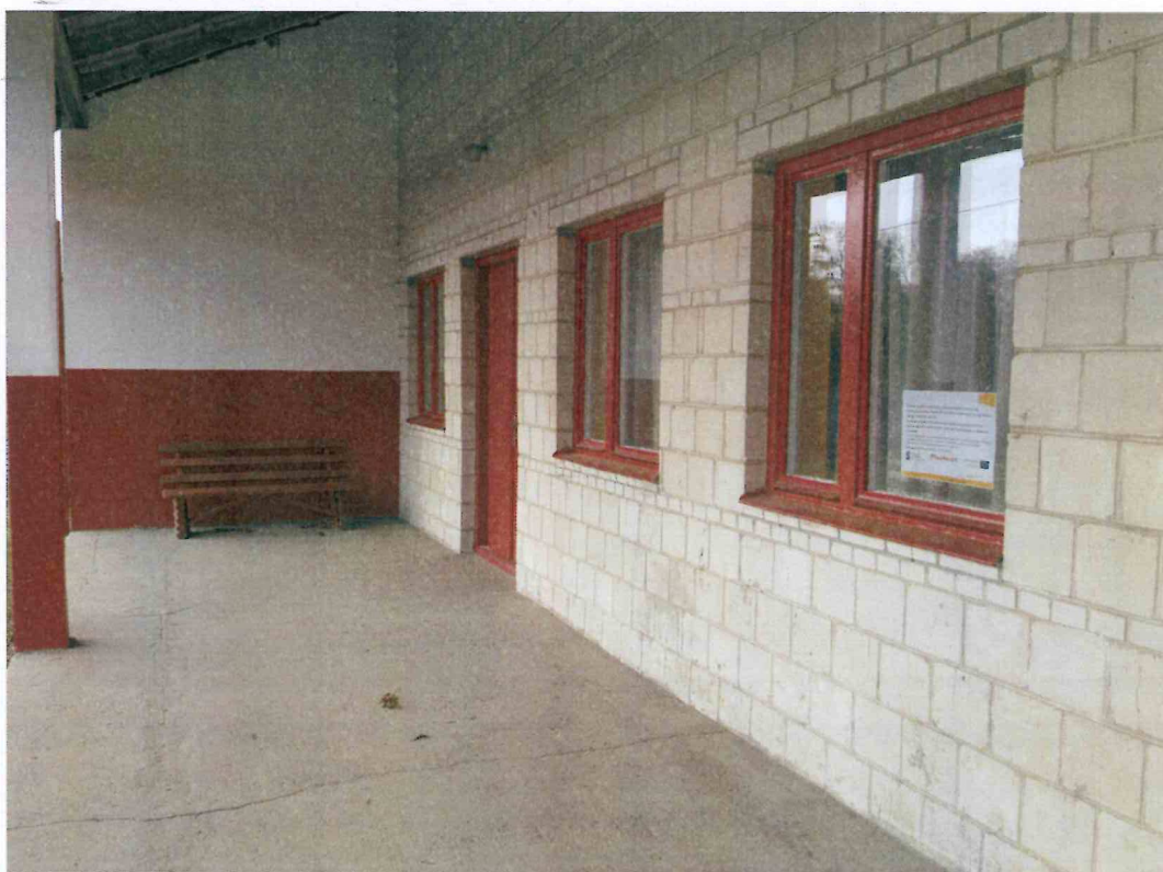
Rys nr 8. Drewniane okna w budynku.
