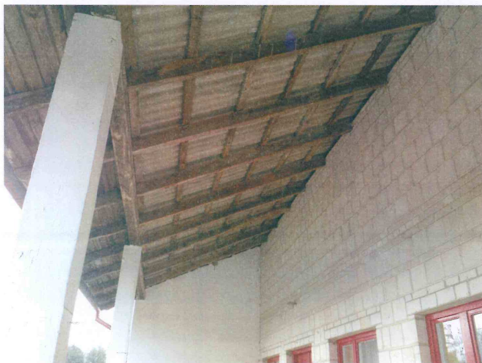
Rys nr 5. Istniejąca konstrukcja dachu (zadaszenie nad głównym wejściem)
